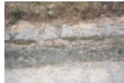
Au niveau de la Pierre Trouée, nous marchons sur le fond de la canalisation et c'est l'occasion de repérer la maçonnerie, les traces de mortier de tuileau et le dépôt calcaire.
