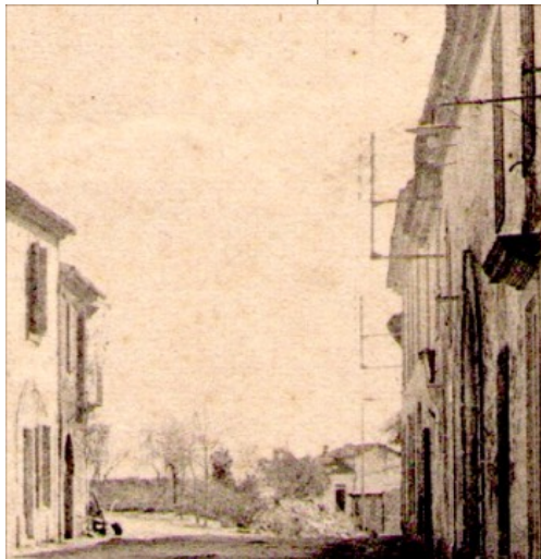
Photo des éléments du réseau 1910 d'éclairage public en 110V
