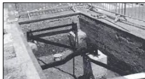
Mécanisme dans la fosse sous les poutres
